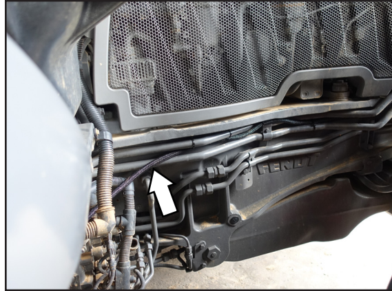
Abb. 19: ISOBUS-Kabelsatz an Fahrzeugrahmen zur Frontsteckdose verlegen
