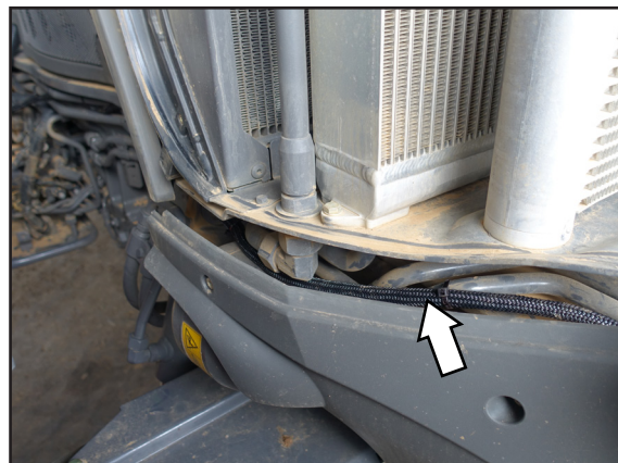
Abb. 20: ISOBUS-Kabelsatz hinter Kühlerplatte verlegen
